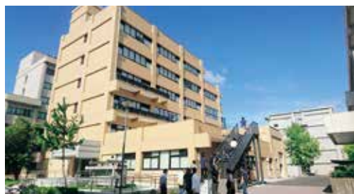
改修が終わった海土棟
