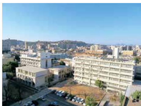
電気電子工学科棟（右）と建築学科棟（左）
