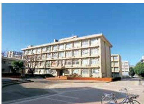
化学生命工学科棟、機械工学科棟、 情報生体システム工学科棟（手前から）
