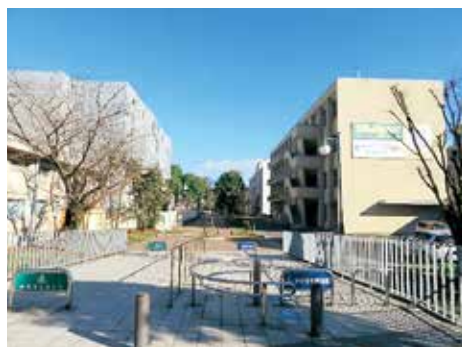
工学部西門から眺める機械工学科1号棟と2号棟
