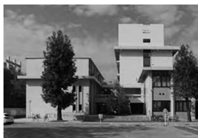
改修後の建築学科1・2号棟 2017.11 撮影
